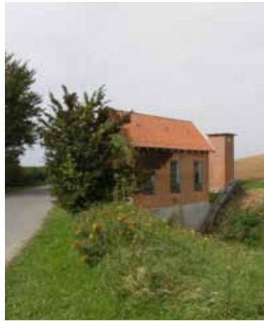
Pumpehus ved Klisebjerg
